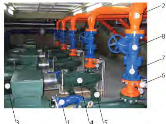
РИС.2. АРМАТУРА, ИСПОЛЬЗУЕМАЯ В УСТАНОВКЕ ДЛЯ ИСКУССТВЕННОГО ОСНЕЖЕНИЯ
